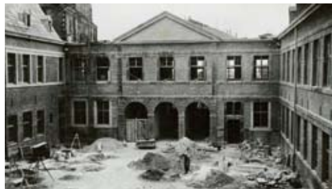
1950 Blick in den Innenhof während des Wiederaufbaus.
